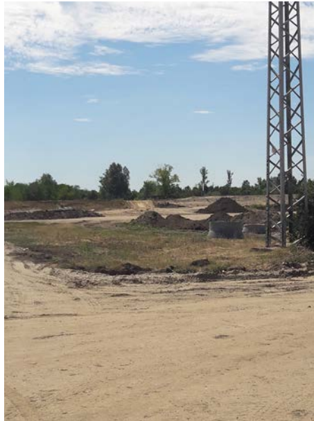
3. kép. A mártélyi úti körforgalom építése (Fotó: Kis É.)
