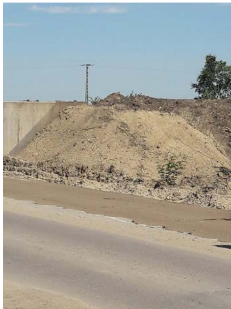
4. kép Épülő betonpillér a körtöltés tetején a mártélyi úti körforgalomtól D-re. (Árvíz idején az út lezárható, hogy a víz ne folyjon át a városra (Fotó: Kis É.)
