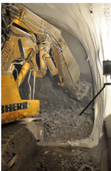
5. ábra A térkiképzésben használt Liebherr gyártmányú bagger és rakodó berendezések
